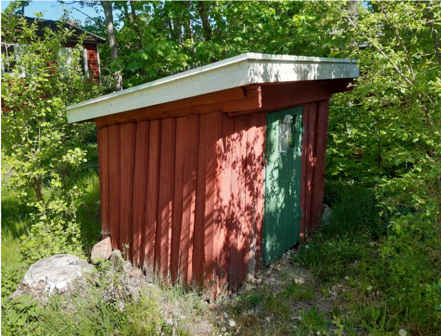
Uthus, byggnad C
