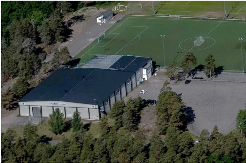
Bild över befintlig sportanläggning
