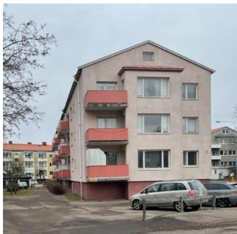
Foto över byggnad på fastighet Ugglan 2
