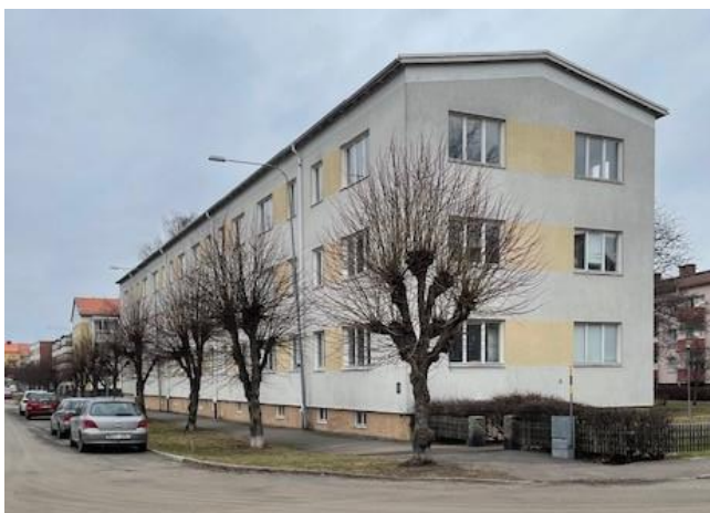
Foto över byggnad på fastighet Ugglan 1
