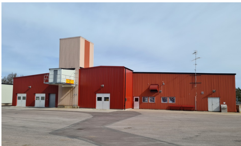
Figur 7 – Reningsverket Ernemar i Oskarshamn
