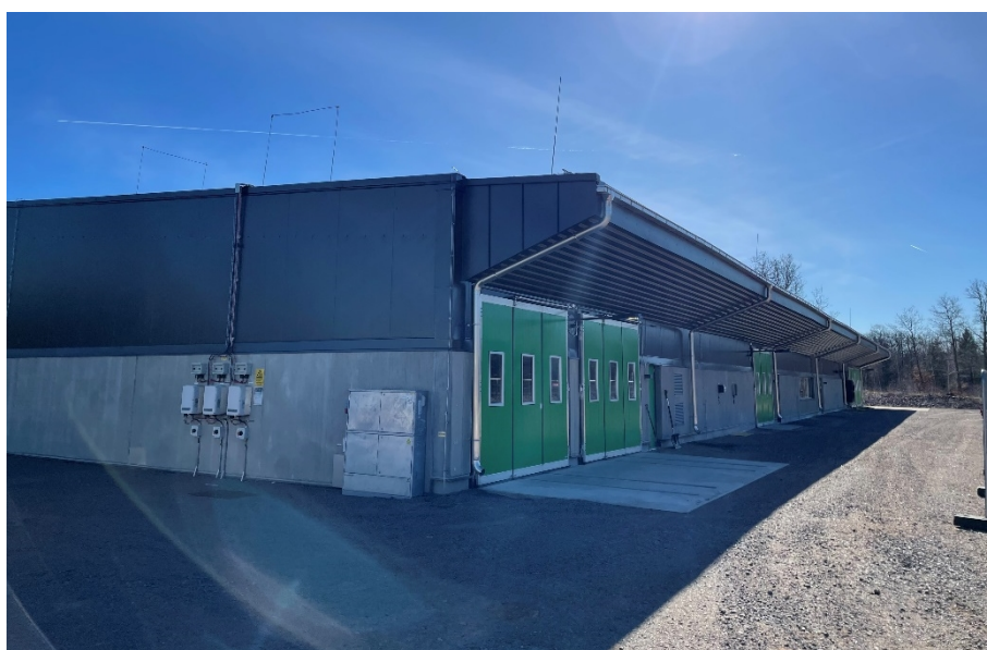
Figur 10 Det nya reningsverket i Figeholm
